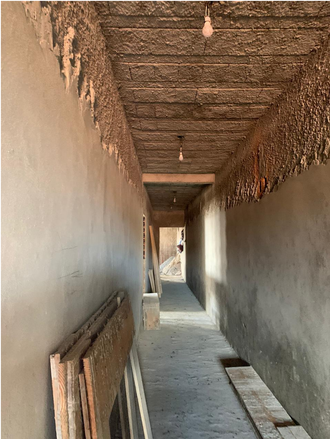
3 Chapisco e Reboco da parte interna
