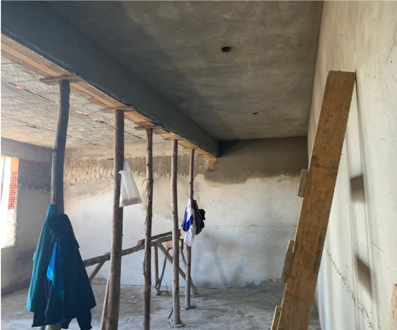
1 Reboco parte interna
