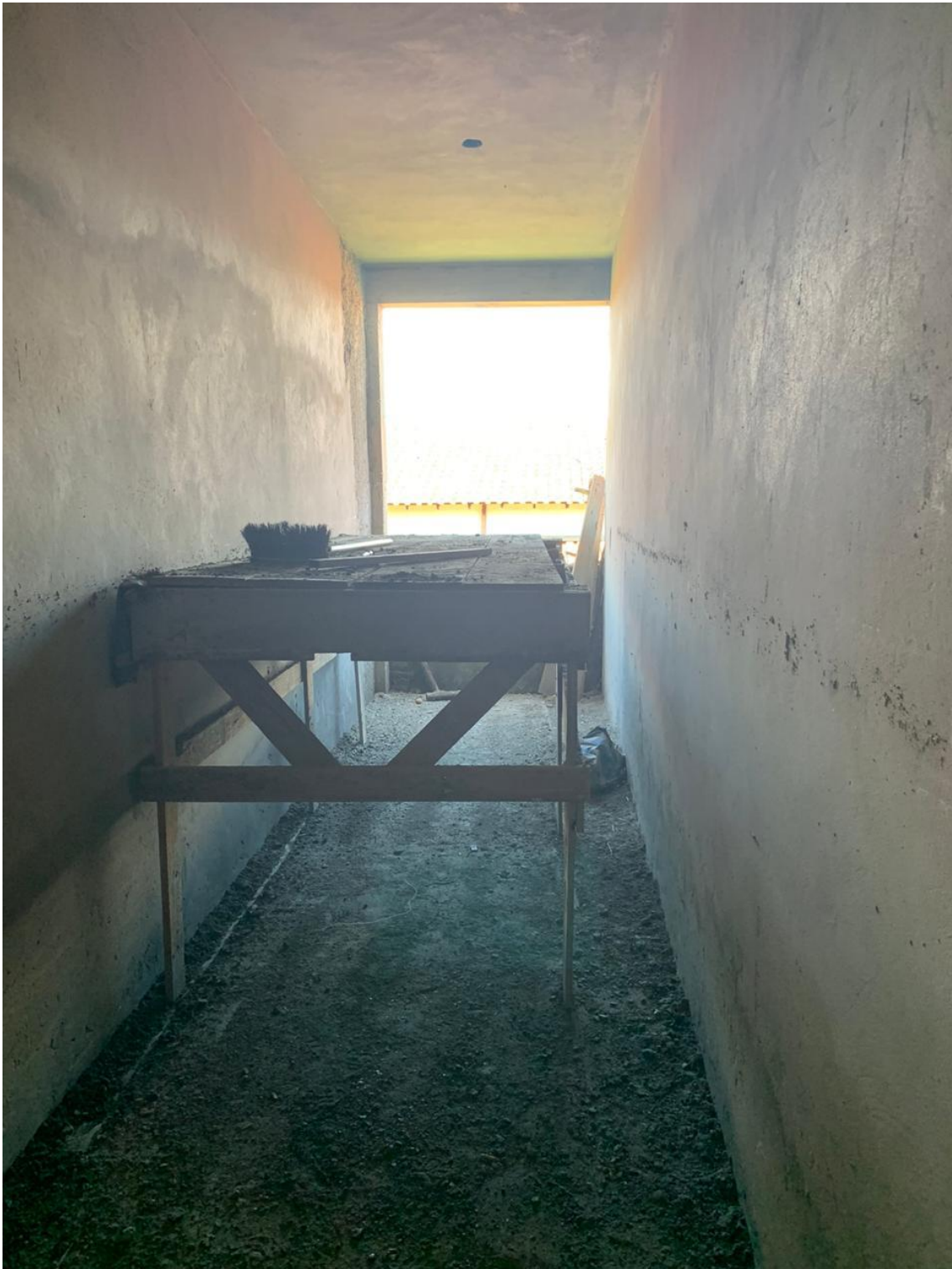
4 Reboco parte interna
